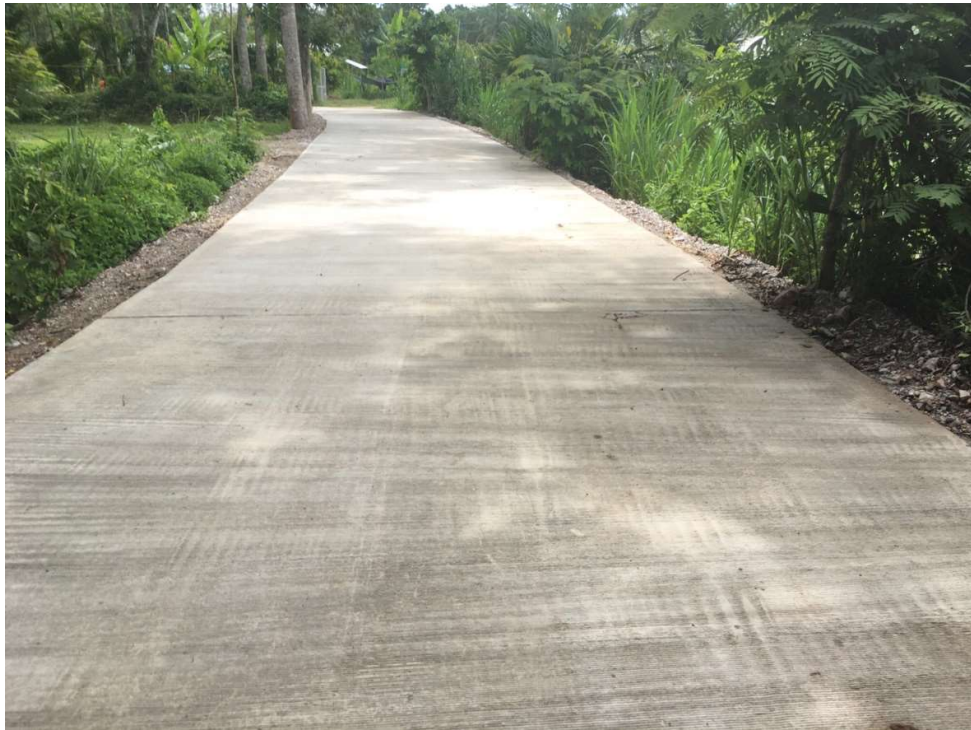
รูปภาพโครงการก่อสร้างถนนคอนกรีตเสริมเหล็กสาย พลุ้ง-หนองโอน หมู่ที่ ๑
